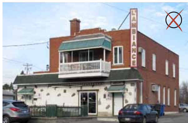
La devanture commerciale de cet ancien immeuble résidentiel est en complète rupture avec son architecture (matériaux, ouvertures, alignement, affichage).
