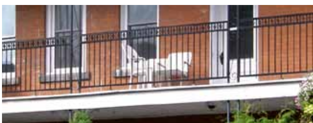
Garde-corps en métal ouvragé, Saint-Hyacinthe
