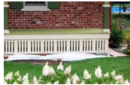
Jupe servant à camoufler le dessous de la galerie, Saint-Hugues
