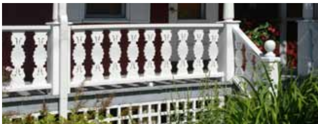
Garde-corps avec barrotins chantournés (planches découpées), Saint-Damase
