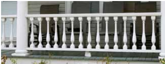
Garde-corps avec barrotins tournés, aussi appelés balustres, Saint-Simon
