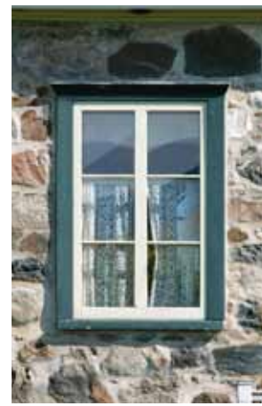
Fenêtre à battants à grands carreaux, 1850-1950, Saint-Damase
