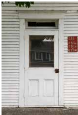
Porte avec vitrage et caissons, surmontée d'une imposte, fin 19 e siècle, Saint-Pie
