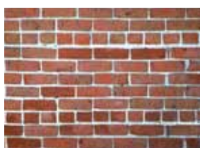
Mur structural en brique reconnaissable par son rang de boutisses à tous les six rangs de briques en panneresse
