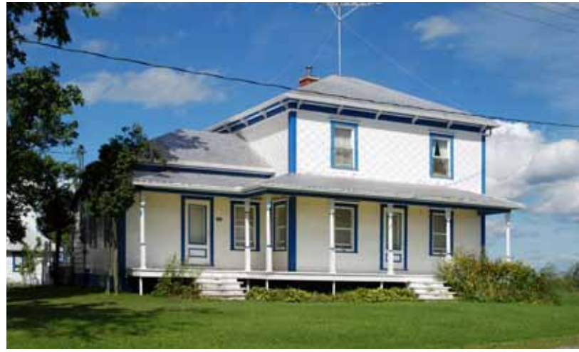
Maison qui a conservé son revêtement de tuiles d'amiante-ciment losangées ainsi que ses éléments décoratifs. La Présentation
