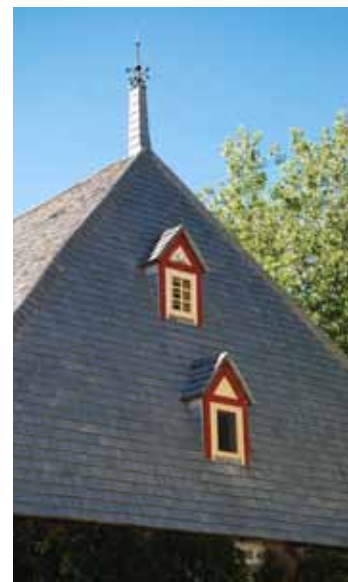
Toiture en bardeau de cèdre, Saint-Simon
