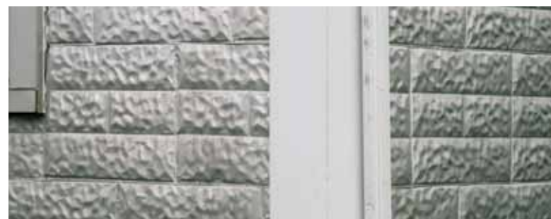
Tôle embossée imitant la pierre de taille sur les murs d'une maison de Saint-Jude
