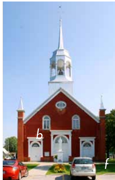
e La brique permet une multitude de jeux décoratifs, comme les parapets et les corniches dont l'assemblage de briques forme des motifs. La Présentation
