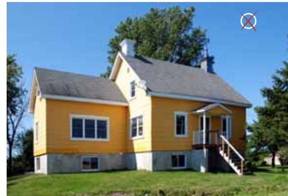
Cette maison est exagérément surélevée sur des fondations trop hautes, ce qui altère sa volumétrie générale.
