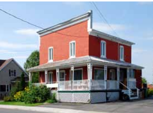
Le parapet dissimulant la toiture en pente donne un tout autre aspect à cette maison cubique, Saint-Louis
