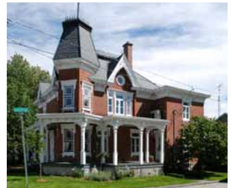
Toiture complexe aux pentes variées sur une maison éclectique, Saint-Liboire
