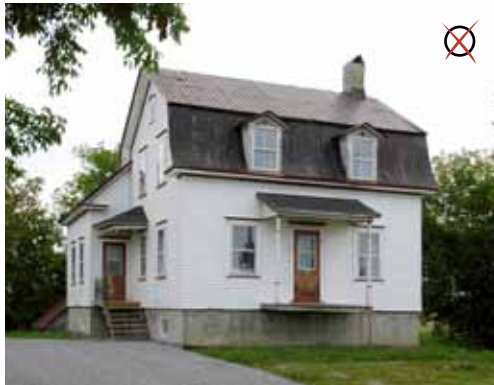
La galerie avant devrait être dotée d'un escalier et d'une jupe ainsi que de plantations qui permettraient de camoufler la fondation disgracieuse.
