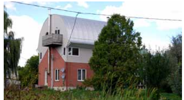
Le surhaussement d'une maison modifie énormément l'apparence de celle-ci. Le recours à un architecte est conseillé pour cette intervention délicate. La Présentation
