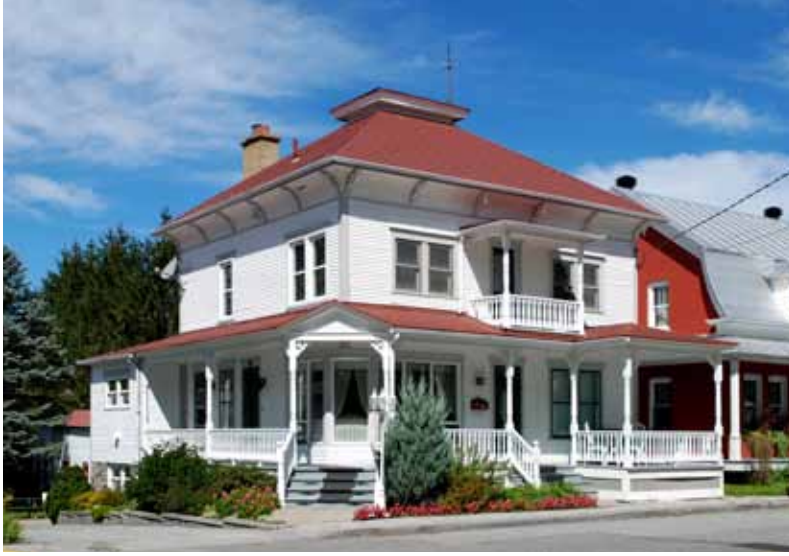
Maison cubique dotée d'une toiture à pavillon (quatre versants), Saint-Liboire
