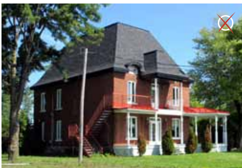
Une toiture non habitable a été ajoutée à cet ancien bâtiment à toit plat. Geste inutile qui écrase le volume.
