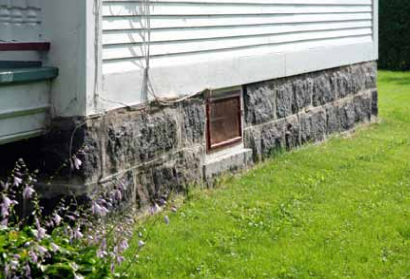
Fondations en pierre bien assises au sol, Saint-Hugues
