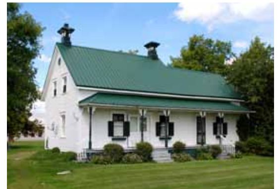
Les maisons traditionnelles québécoises sont généralement de bons exemples de bâtiments appliquant des principes écoénergétiques. La Présentation
