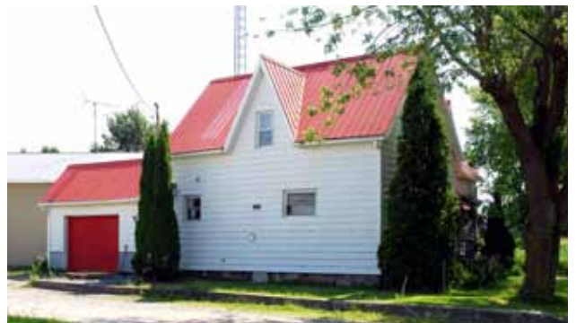
La suppression de la porte et le remaniement des fenêtres sont des interventions irréversibles.
