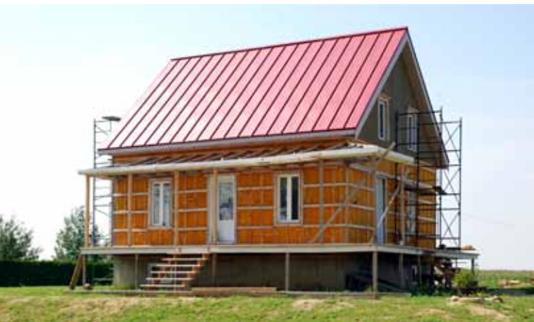
Maison en rénovation, Saint-Marcel-de-Richelieu
