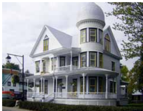
Plusieurs secteurs du centre-ville de Saint-Hyacinthe sont assujettis à un PIIA, comme ici sur la rue Girouard Ouest.
