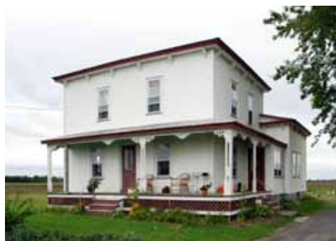
Plusieurs bâtiments patrimoniaux de la MRC des Maskoutains sont situés en zone agricole. Saint-Valérien-de-Milton.
