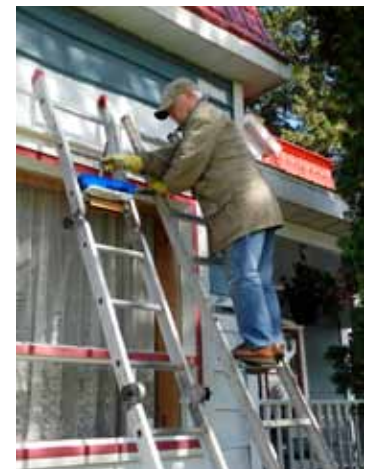
Application d'une couche de peinture sur le revêtement, Saint-Liboire
