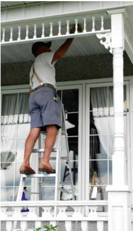
Travaux d'entretien, Saint-Simon
