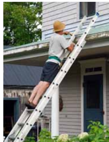
Grattage de la peinture écaillée sur l'auvent de la galerie, Saint-Louis
