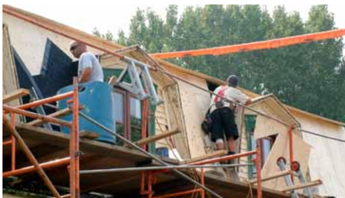
Remplacement du parement d'une toiture mansardée.
