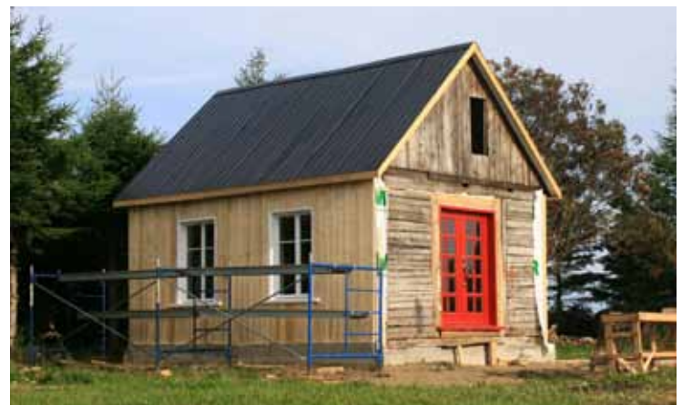
Bâtiment secondaire dont la structure d'origine est en voie d'être recouverte par un parement en bois compatible.
