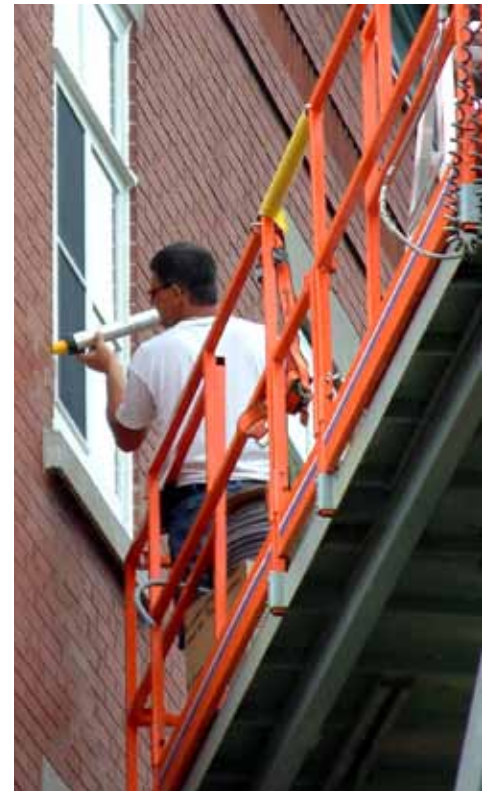
Calfeutrage d'une fenêtre
