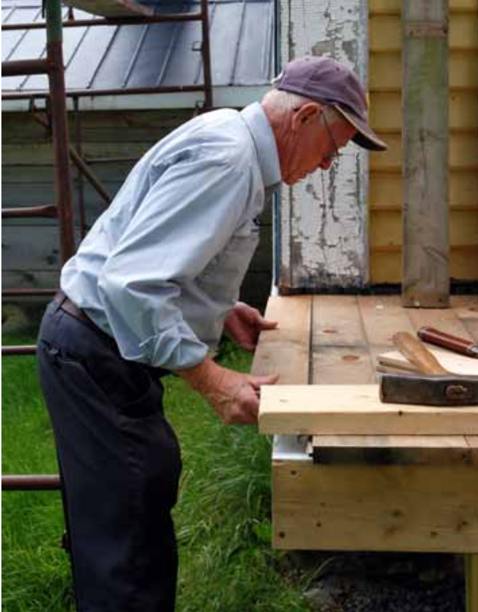
Réfection d'une galerie, Saint-Liboire
