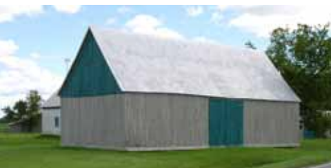
Toit à pignon droit, 19 e siècle, La Présentation
